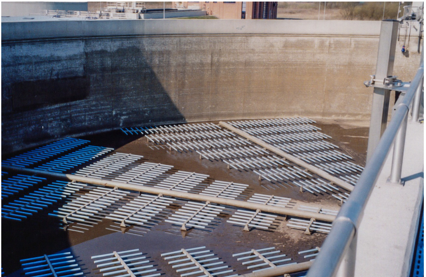
BUTTING-Rohre für mehr Lebensqualität, hier in einer Kläranlage
