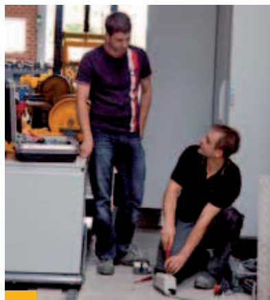
Auch an Hallenerweiterungen und -neubauten bei BUTTING sind die Elektriker maßgeblich beteiligt
