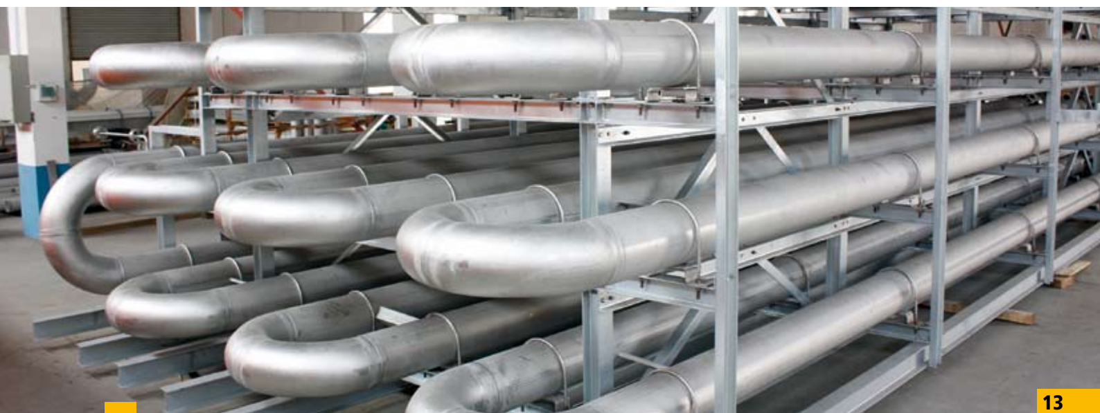
Tubos em espiral pré-fabricados para uma usina de biodiesel na China
