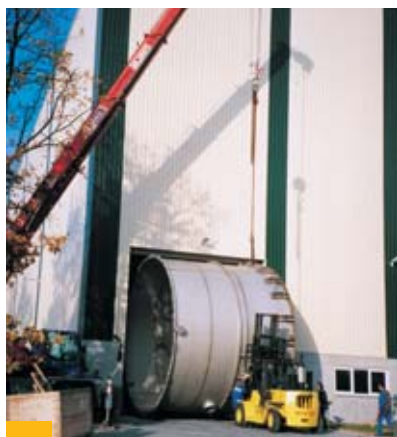
Element konstrukcyjny zbiornika opuszcza halę produkcyjną w Schwedt
