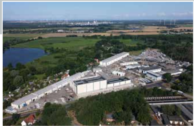
BUTTING Anlagenbau in Schwedt
